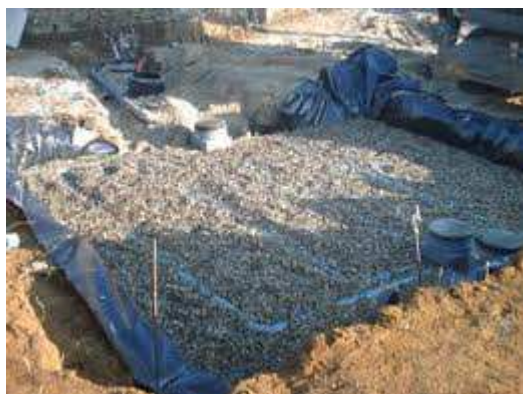
Photo 1 : Filtre à sable vertical drainé avant remblaiement
