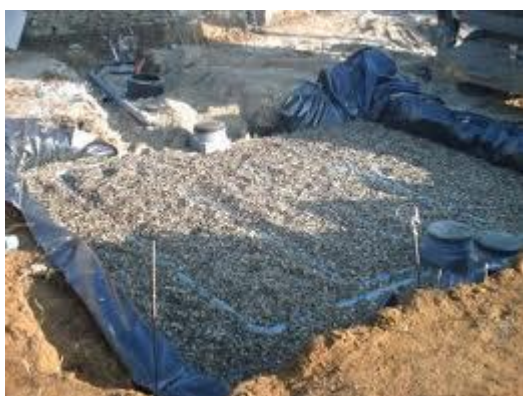
Photo 1 : Filtre à sable vertical drainé avant remblaiement
