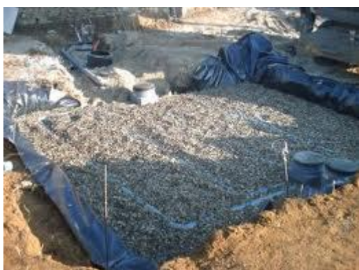
Photo 1 : Filtre à sable vertical drainé avant remblaiement
