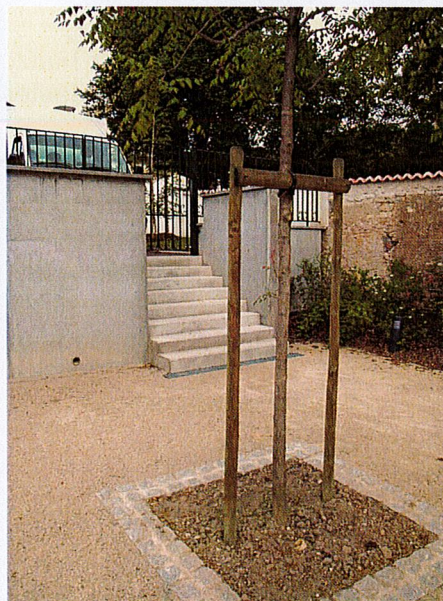
Exemple de tuteurage bipode pour arbres tige (2 tuteurs + 1 lisse en partie haute)
