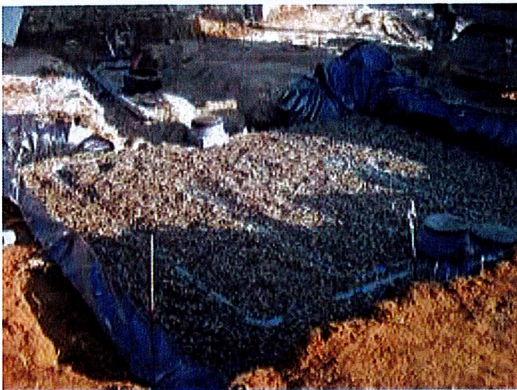
Photo 1 : Filtre à sable vertical drainé avant remblaiement
