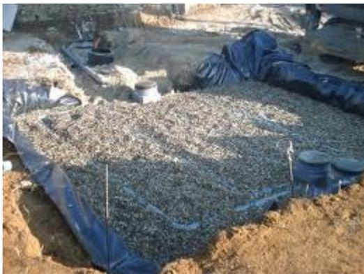
**Photo 1 : Filtre à sable vertical drainé avant remblaiement**
