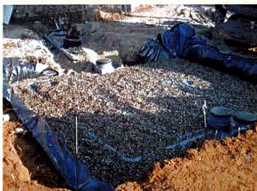
**Photo 1 : Filtration à sable vertical drainé avant remblaiement**
