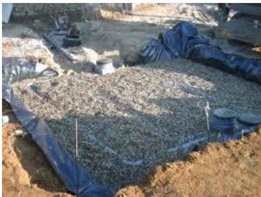
Photo 1 : Filtre à sable vertical drainé avant remblaiement
