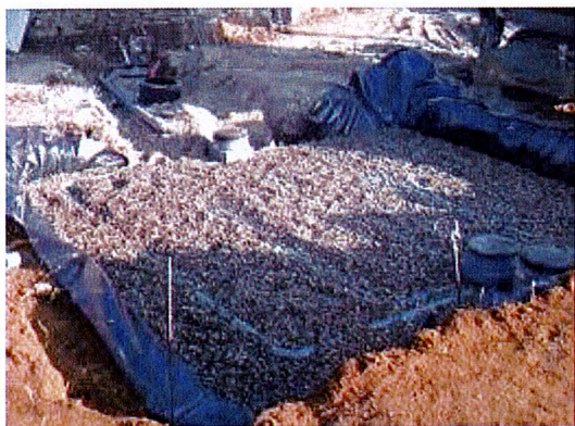
Photo 1 : Filtre à sable vertical drainé avant remblaiement
