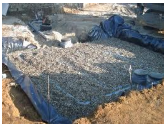
Photo 1 : Filtre à sable vertical drainé avant remblaiement
