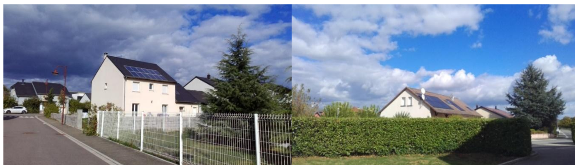
Installations de solaire photovoltaïque sur le territoire de la CCCE
